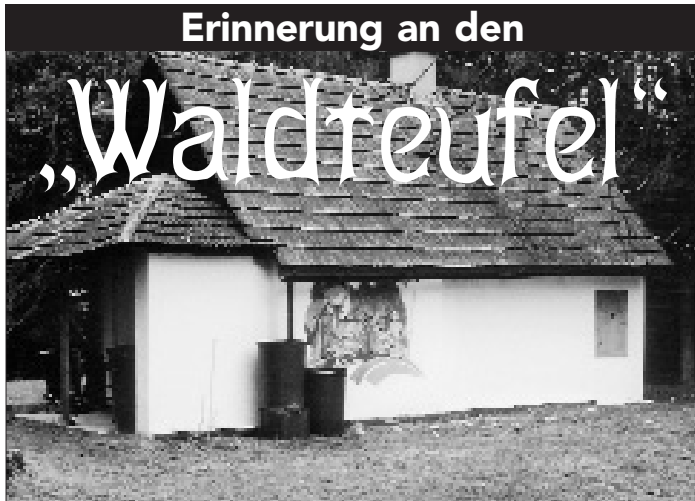
Das „Waldteufelhaus“ im jetzigen Zustand.
