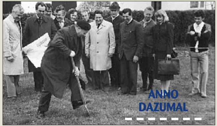
Pfarrer Anton Neuhold führte im Jahr 1982 den Spatenstich für den Neubau des Pfarrkindergartens durch. In Vertretung der Gemeinde und der Pfarre verfolgten Bürgermeister Vinzenz Kainz, Baumeister Ing. Reiter, Herta Rupp, Richard Seitz, Vizebürgermeister Karl Lorber, Anrainer Karl Brodschneider, Alois Adam, Dorothea Graggl und Johann Glanz gespannt den ersten Stich in die Erde zum geplanten Neubau des Pfarrkindergartens. (Text und Foto Johann Högler).
