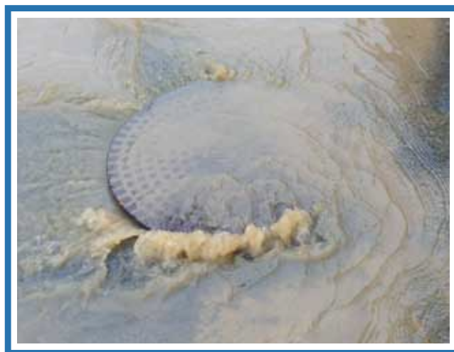
Lösung: illegale Fremdwassereinleitung.
