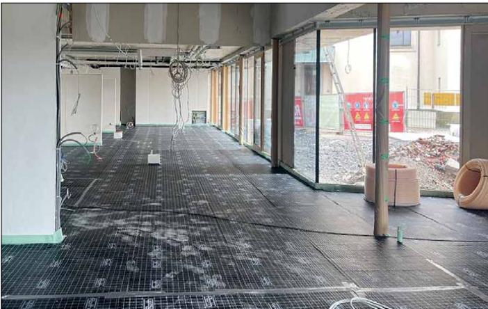
Der Bürgerservicebereich kurz vor der Verlegung des Estrichs. Inzwischen werden schon die letzten Arbeiten an der Decke durchgeführt.
