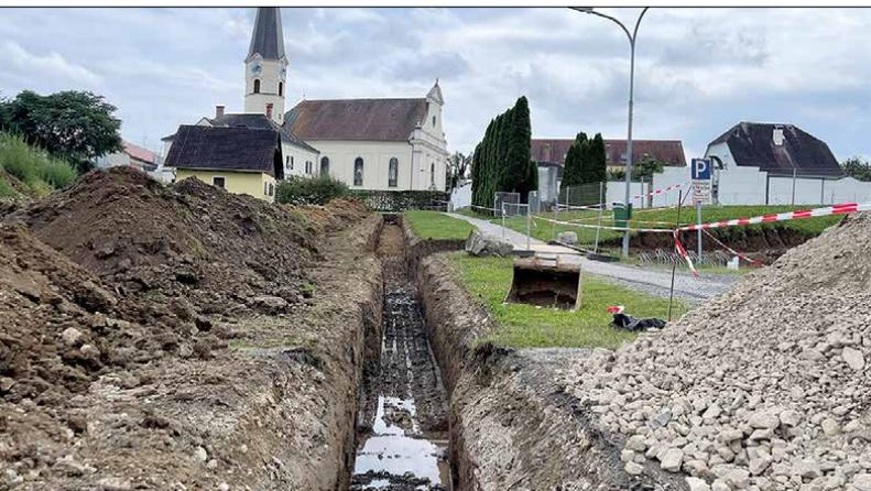
In Richtung ESV-Halle und der Forster Straße wurde das Nahwärmenetz erweitert. Auch die Glasfaser-Verrohrung wurde mitverlegt.
